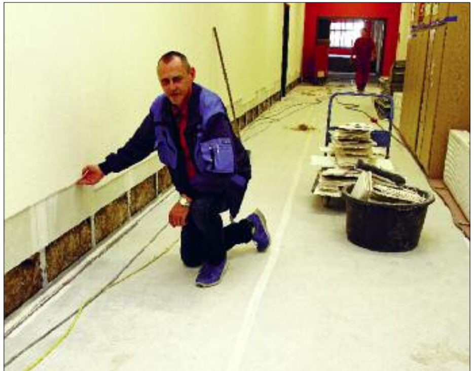
Hausmeister Jonny Schieblich überwacht die laufenden Sanierungsarbeiten im Wasserbau. Foto: rs.
